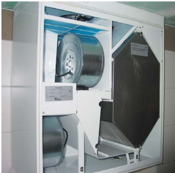
Obr. 6 O kvalitní vnitřní prostředí a neustálý přísun čerstvého vzduchu se stará větrací jednotka. Díky vysoce účinnému rekuperačnímu výměníku je vzduch ohříván na teplotu blízkou pokojové i v nejtěžších mrazích. Dohřát je pak potřeba jen zbylých pár stupňů.
